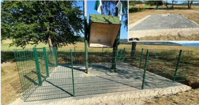
An Vogelstange und Schießstand wurde neues Pflaster verlegt, sowie ein Zaun errichtet. Wir bedanken uns bei der Fa. Frank Schulte für die Unterstützung.
